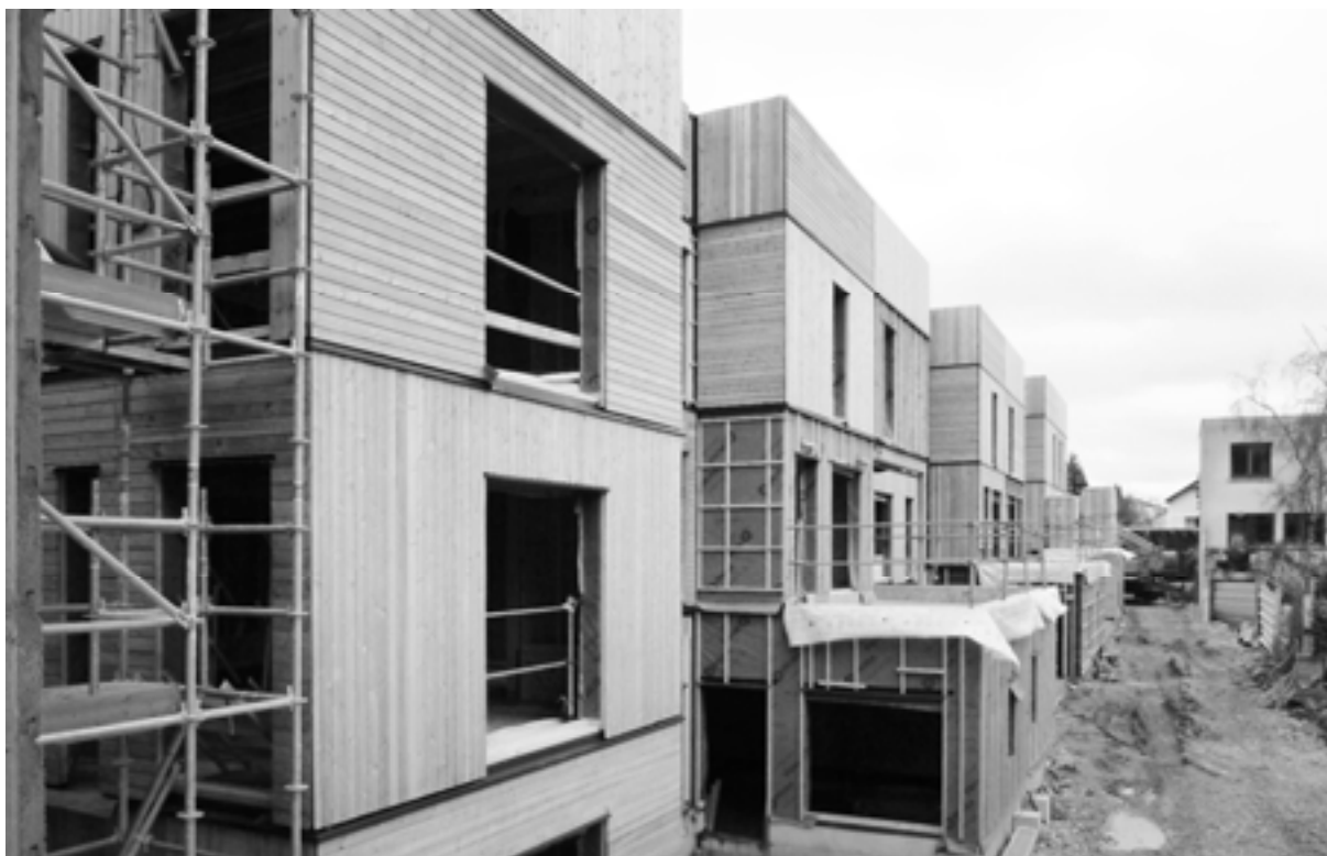
Projet Rue Branly – Travaux – Janvier 2014
