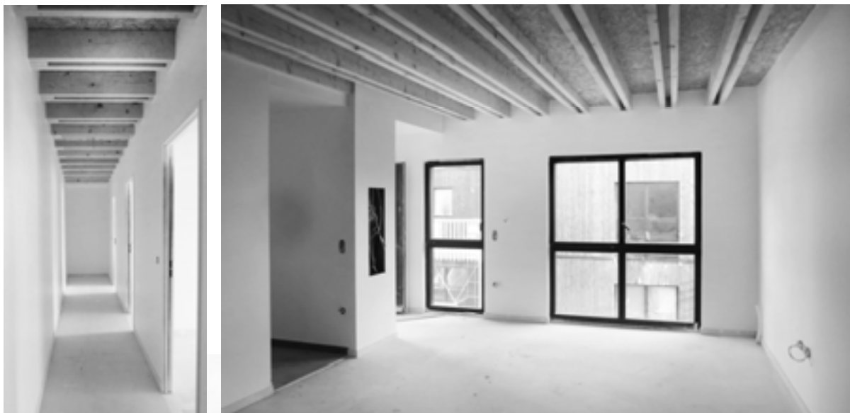
Rue Dolet, Bâtiment B, Logement T4 R+2, Travaux Janvier 2014.
