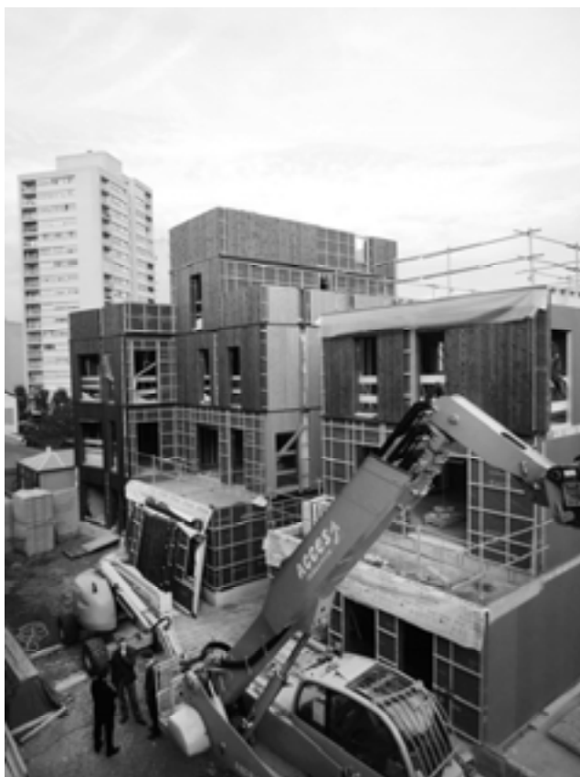
Projet Rue Dolet – Travaux – Octobre 2013
