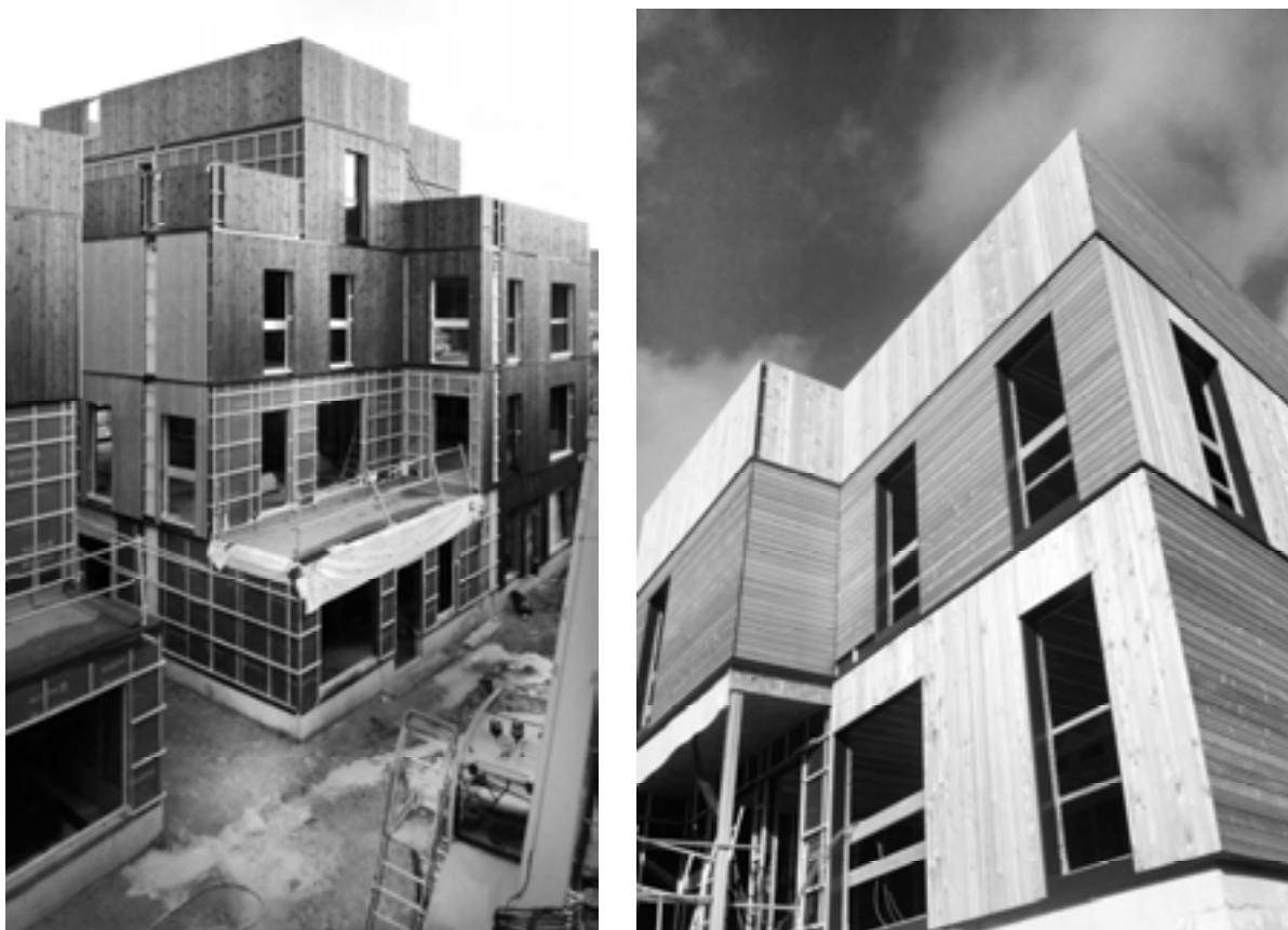
Rue Dolet, Bâtiment A, Travaux Décembre 2013.
