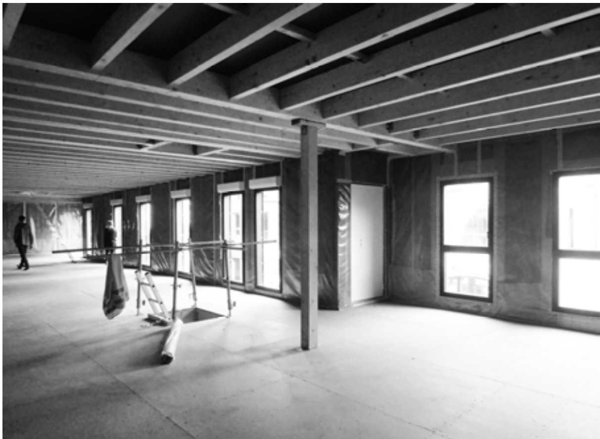
Rue Dolet, Bâtiment B, Logement T4 R+1, Travaux Novembre 2013.
